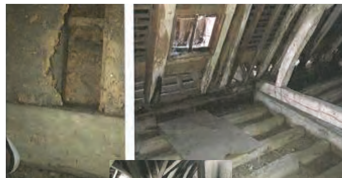
Planchers des combles avec solivages apparents ou recouverts par des plaques de bois aggloméré.
